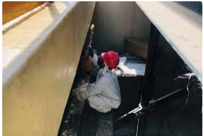
Lining FRP layer (M+M+SM) onto HF-161 layer
