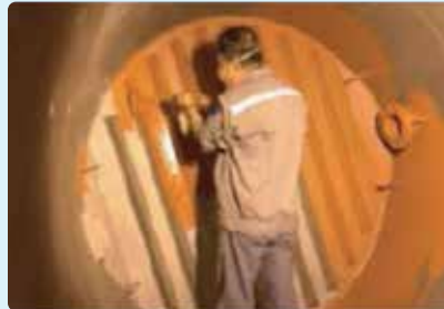
Apply primer coating
