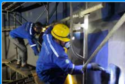
Shell tank primer and bonding
